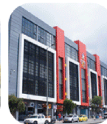
Centro comercial Puerto Rico (Silverbay Properties, constructora puerto rico) Bogotá, Colombia
